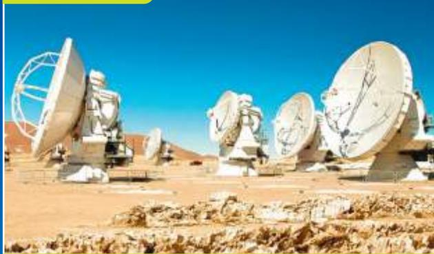
El observatorio **ALMA** (*Atacama Large Millimeter/ Submillimeter Array*) cuenta con 66 antenas que funcionan sincronizadamente, formando un único radiotelescopio que capta ondas infrarrojas y de radio.
